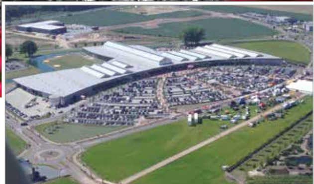
Neubau der Gartenwelt Emsbüren mit einer überdachten Fläche von 24.000 m 2
