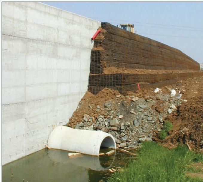
Figura 5 - La falda alla base del rilevato
