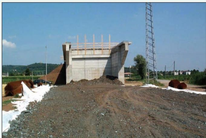
Figura 2 - Lo Stablenka® 400/50 parzialmente coperto con il materiale di riempimento
