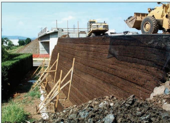
Figura 3 - Le fasi di realizzazione della terra rinforzata
