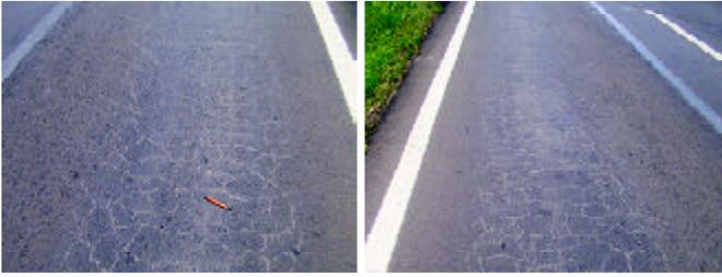
Figura 2 Padrão de trincamento no trecho antes da restauração
