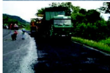
**Figura 11** Espalhamento da camada de concreto betuminoso usinado a quente
