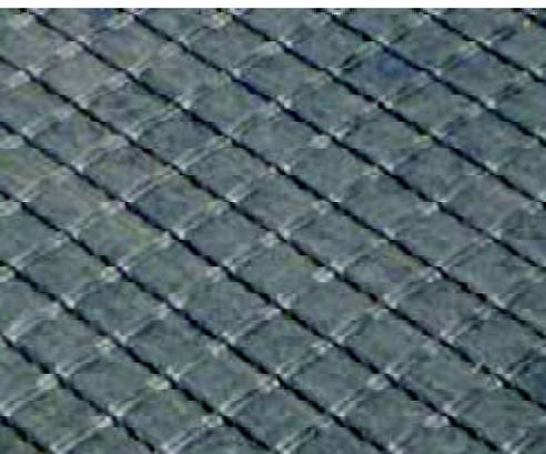
**Figura 8** Detalhe da geogrelha de poliéster já instalada no campo
