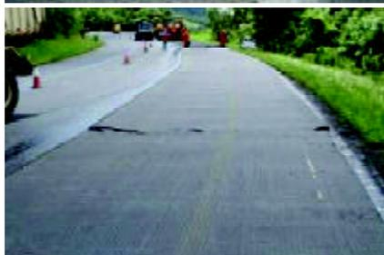
**Figura 10** Instalação da geogrelha
