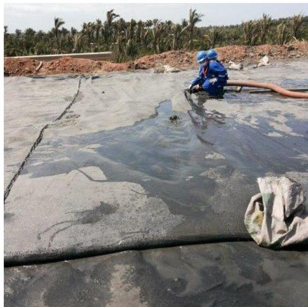
Figura 4 – Teste em campo do preenchimento das geoformas.
