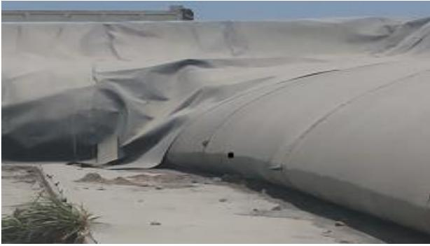
Figura 10 – Posicionamento da geomembrana sobre o dique.
