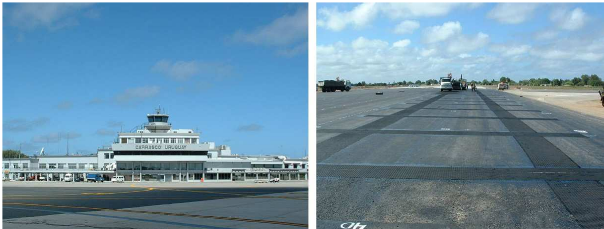
Figura 7: Terminal Aeropuerto Internacional de Carrasco y Geomalla Instala (2004).
