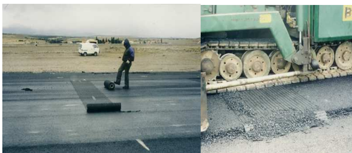
Figura 11: Detalles de la instalación de la geomalla en el Aeropuerto Balmaceda, Chile.
