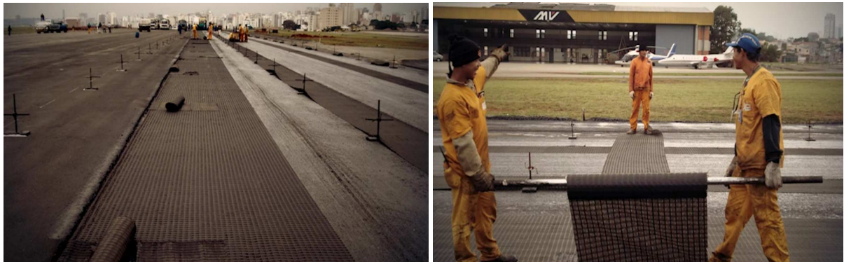
Figura 4: Detalle de instalación de la geomalla sentido longitudinal y transversal.
