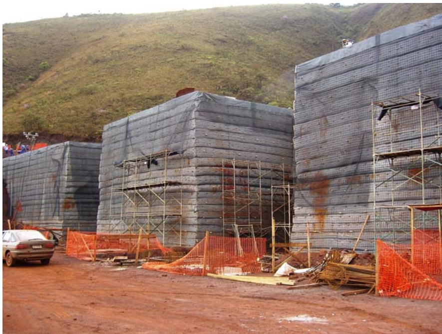
Figura 3 – Vista de uma das contenções em Itabirito
