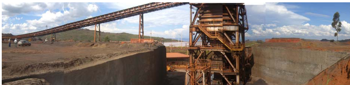
Figura 6 – Vista geral da contenção na área da usina de pelotização.
