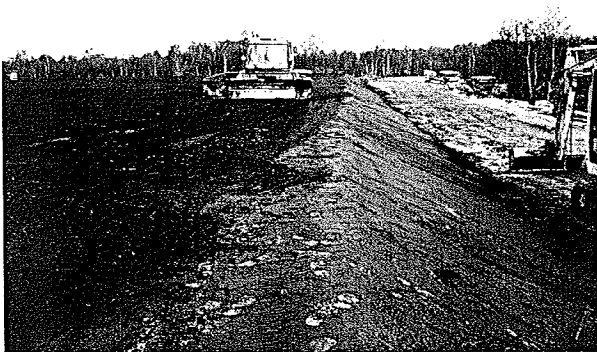
Abbildung 3.2-14 Einbau Rekuboden (Bild Fa. Knoll)
