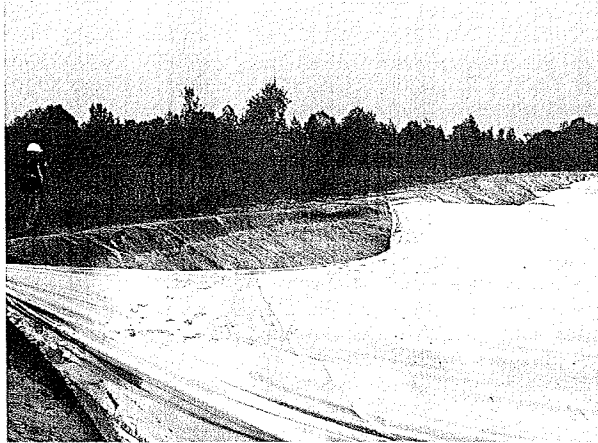
Abbildung 3.2-8 Verlegung Großpanel mit Seilwinden
