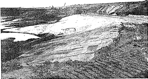
Abbildung 3.1-4 Profilierung der Böschungen auf 1:3
