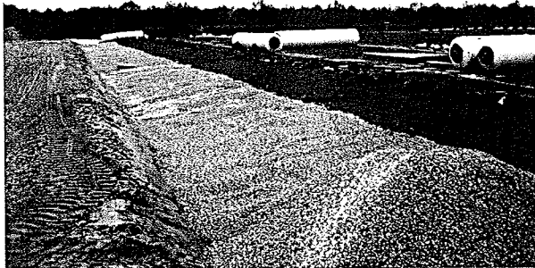
Abbildung 3.2-13 Oberflächenabdichtungssystem (Bild Fa. Knoll)
