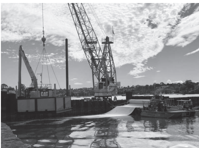
Fig. 7 - Posa del geocomposito attivo.
