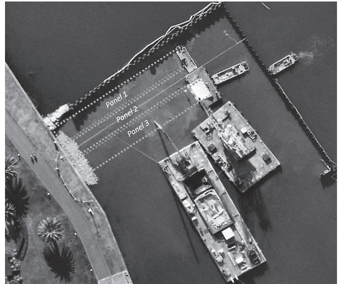
Fig. 8 - Installazione dei vari pannelli di geocomposito.
