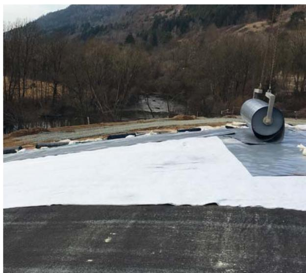
**Figura 4.** Fasi di posa del capping. In primo piano si vede il geocomposito bentonitico calcico; dietro, di colore bianco, il geocomposito attivo con carboni attivi; in grigio, la membrana in LDPE con incorporato lo strato in alluminio.
