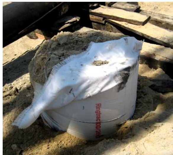
Fig. 8 - Colonna incapsulata con geotessile tubolare Ringtrac® 100/250, riempita di sabbia compattata
