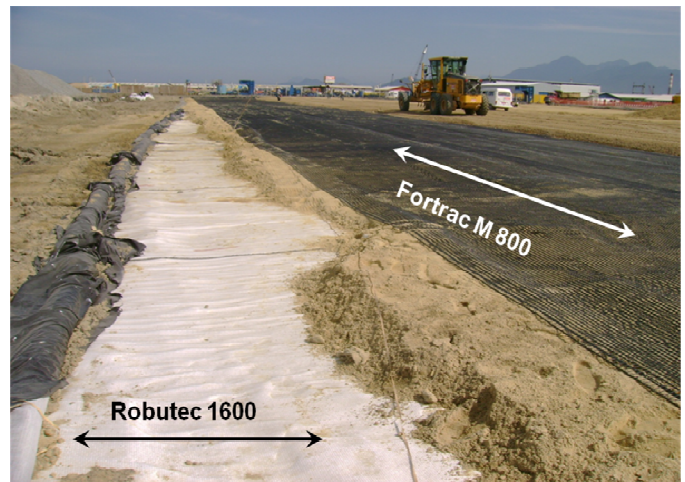
Fig. 7 - Rinforzi posati: nel senso longitudinale (E-O) geogriglia Fortrac® M 800, nel senso trasversale (N-S) i geotessili Robutec® 1600 con uno strato di sabbia intermedio
