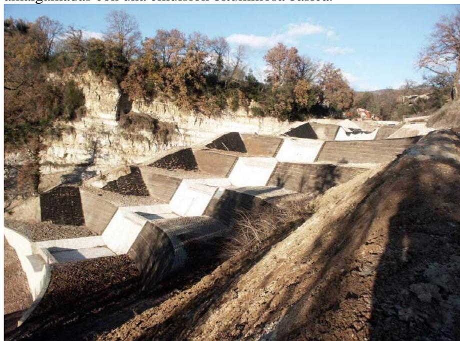
**Fig 9.** Vista general. Taludes reforzados, canal central y georedes antierosión en los taludes laterales.
