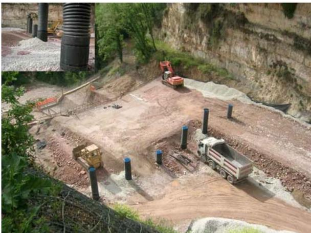
Fig. 6. Tubos verticales que interconectan las plataformas drenantes horizontales, ambos filtrados con un geotextido.
