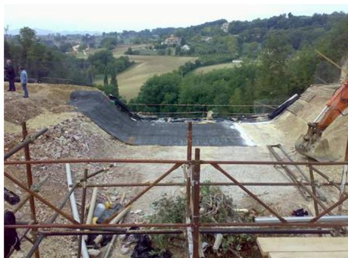
**Fig 8.** Sección del torrente canalizado “Fosso della Rocca”. Instalación del geocompuesto bentonítico.
