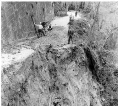
**Fig. 1:** Zona de derrumbe al pie del muro de contención que circunda la ciudad.
