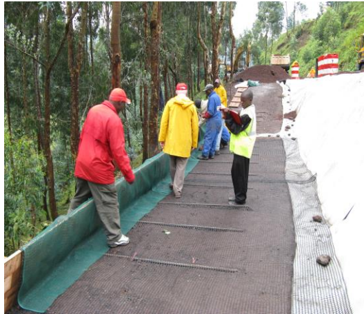
Figure 8: Installation du géogrille et du géotextile
