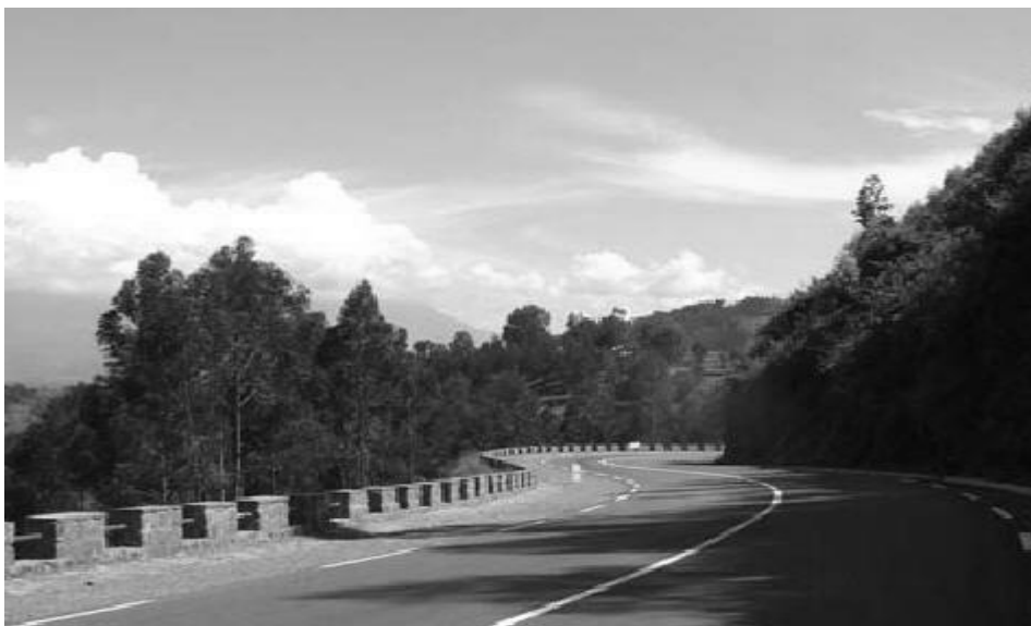
Figure 11 : Vue de l'ouvrage achevé
