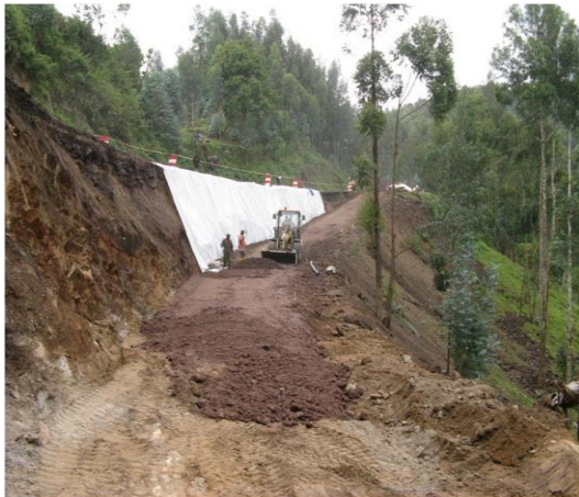
Figure 7: Géotextile de séparation et filtration
