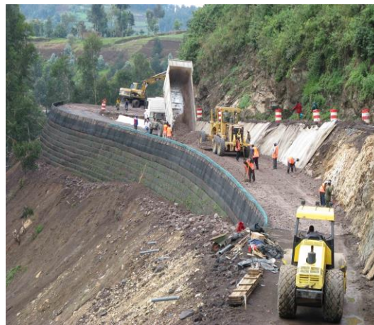
Figure 10: Vue globale de l'ouvrage en cours de construction
