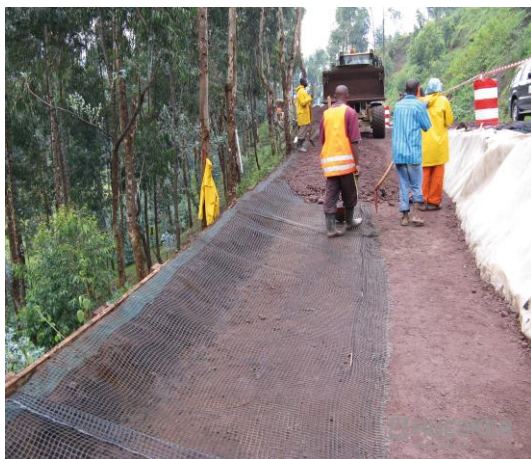
Figure 9: Ancrage du géogrille par retournement
