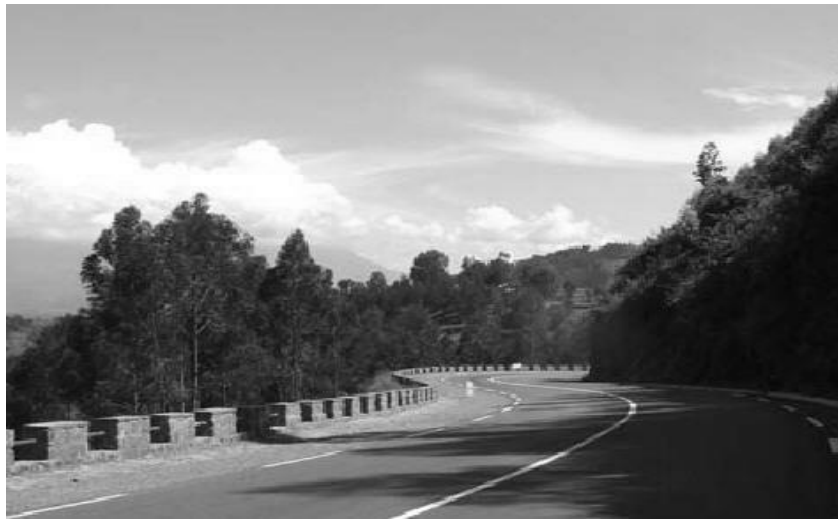
Figure 12. Vue de l'ouvrage achevé
