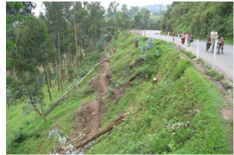
Figure 5. Vue du site et début des travaux de terrassement
