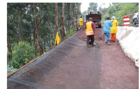
Figure 9. Ancreage du géogridle par retournement
