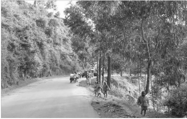
Figure 10. Vue de l'ouvrage avant le démarrage des travaux
