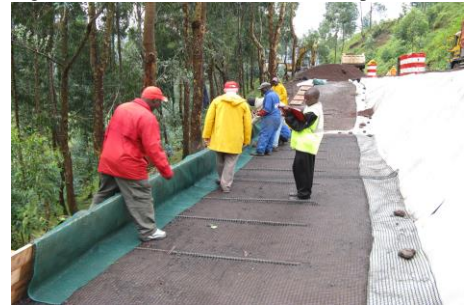
Figure 8. Installation d'un coffrage provisoire, du géogridle et du géotextile anti-Erosion
