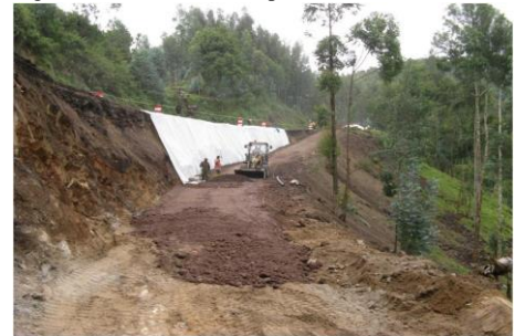
Figure 7. Installation du Géotextile de séparation
