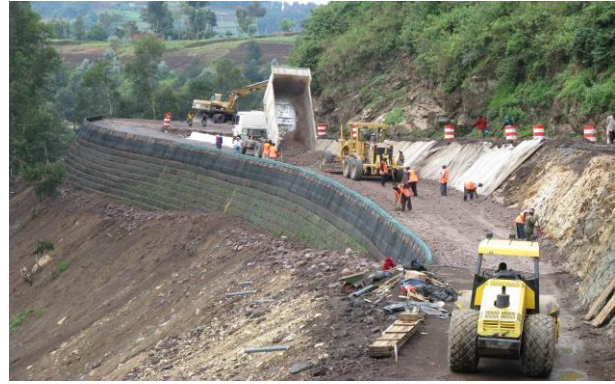
Figure 11. Vue globale de l'ouvrage en cours de construction
