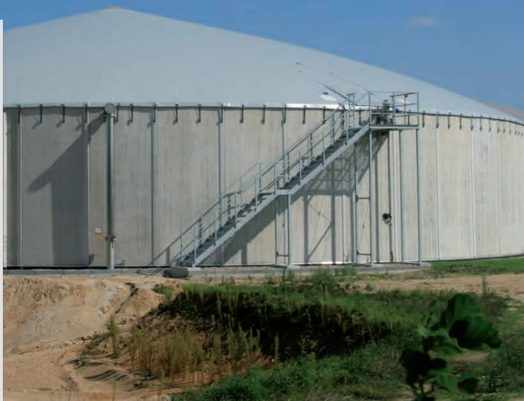
La copertura a strato singolo a tenuta stagna assomiglia, per struttura e tecnica costruttiva, alla semplice copertura per silos. Si differenzia per il labbro interno, che in questo caso viene fissato ermeticamente alla parete interna della vasca. Questo tipo di copertura è comunemente usato per impianti di digestione anaerobica che non richiedano volumi di stoccaggio variabili.
