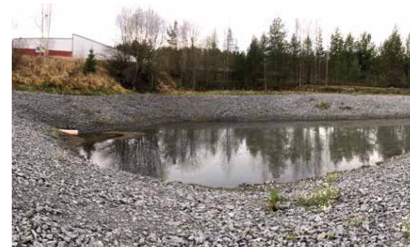
Trattamento delle acque prodotte dall'attività mineraria Finlandia | Le acque ricche di metalli provenienti da attività estrattiva e mineraria vengono trattate in opportuni bacini di decantazione. In una miniera di nichel, il trattamento dell'acqua è stato effettuato in due bacini filtranti, rivestiti con Tektoseal Active HM.
