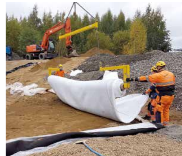
Trattamento delle acque di ruscellamento Finlandia | Le acque di ruscellamento che scorrono su terreni contaminati da PAH e CHC vengono trattate in un bacino di stoccaggio. Posando sul fondo del bacino i nostri Tektoseal Active AS e AC, gli inquinanti vengono filtrati prima che l'acqua si disperda nell'ambiente. Le sponde del bacino sono state impermeabilizzate con uno speciale geocomposito bentonitico.
