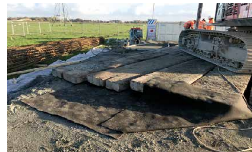
Lavori in presenza di falde acquifere Germania | I cantieri nelle zone di falda acquifera protetta richiedono un'attenzione particolare nei confronti della contaminazione del suolo e delle acque stesse. Le perdite di lubrificanti e carburanti dai macchinari sono infatti una fonte di pericolo che può essere adeguatamente contenuta dal Tektoseal Active AS. In questo cantiere, ad esempio, il filtro anti-contaminanti è stato posizionato sotto una macchina perforatrice.
