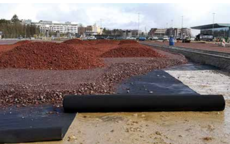
Filtro anti-inquinanti sotto un parcheggio Lussemburgo | Il Tektoseal Active AS è stato posato sotto uno strato di ghiaia di un parcheggio per prevenire l'infiltrazione dei contaminanti nel sottosuolo. Il geocomposito consente all'acqua di passare liberamente attraverso lo stesso, mentre assorbe efficacemente oli, carburanti e altri inquinanti (ad esempio i metalli pesanti). Questo consente una progettazione sicura delle aree di transito e parcheggio permeabili all'acqua.
