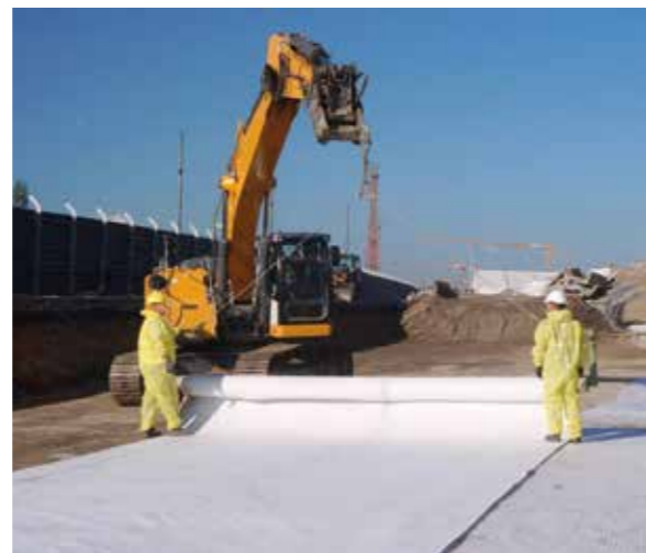
Filtro anti-odori e anti-inquinanti in siti contaminati Germania | Capping di un sito contaminato come misura di sicurezza durante i lavori di costruzione. Posa in opera facile e veloce del Tektoseal Active AC. Gli inquinanti e gli odori vengono adsorbiti dal carbone attivo e non riescono a raggiungere la superficie. Applicazione come protezione temporanea o permanente di un sito contaminato.
