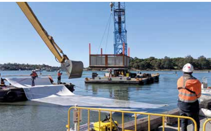
Messa in sicurezza di sedimenti contaminati Australia | Messa in sicurezza di sedimenti ad elevato contenuto di PAH e CHC in una baia di Sydney. Posa di circa 5.000 m 2 di Tektoseal Active AC come barriera agli inquinanti per migliorare la qualità dell'acqua.
