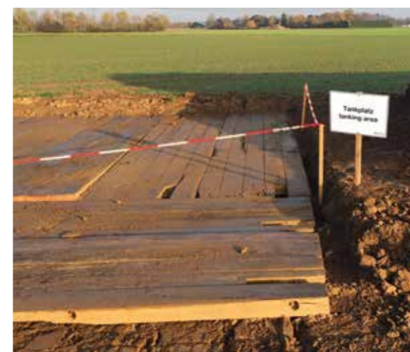
Stazione temporanea di rifornimento carburante Germania | Nell'ambito di un progetto di realizzazione di un'area verde è stata creata un'area di rifornimento temporanea per i macchinari da cantiere. Con l'uso del nostro Tektoseal Active AS è stato possibile proteggere il sottosuolo dalle eventuali perdite di carburante. Le tavole di legno sopra il geocomposito attivo garantiscono la traspirabilità e la protezione dello stesso dal danneggiamento meccanico e dai raggi UV.
