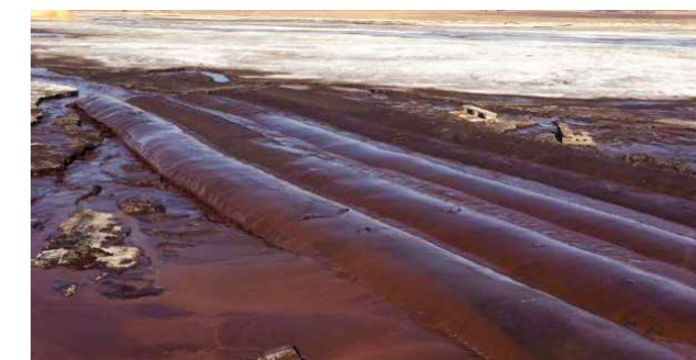
SoilTain Protect - Operazioni di riempimento
