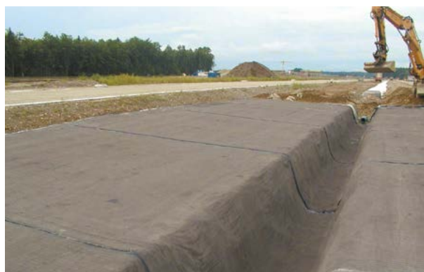
Protezione della falda
