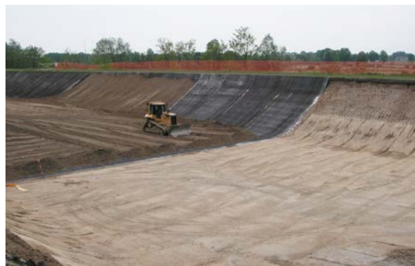
Impermeabilizzazioni di canali
