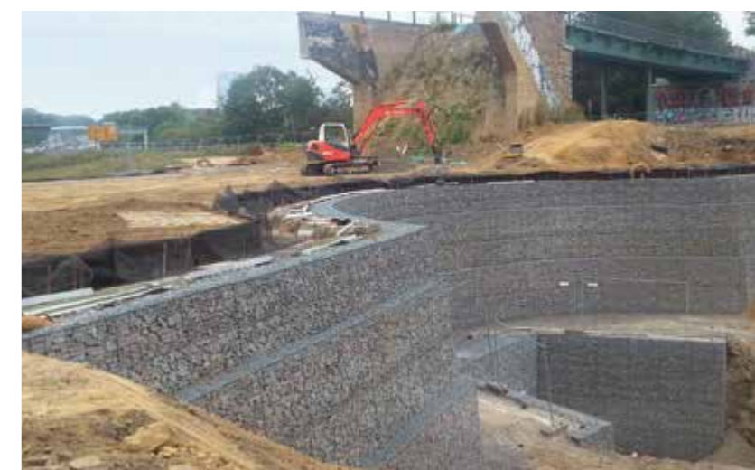
Offenlegung des Flusses Schondelle Deutschland | Teilprojekt der ökologischen Verbesserung der Emscher – Erdkörperaufbau mit verllorener, integrierter Schalung sowie einer Vollgabionen-Vorsatzschalung – Konnte die ursprünglich geplanten Betonstützwinkel ablösen – Bau in drei 5 m hohen Etagen.
