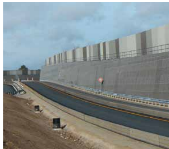
Hochabsorbierende Lärmschutzwand Deutschland | Bau einer hochabsorbierenden Lärmschutzwand beim 6-spurigen Ausbau der A3/A73, Fürth-Erlangen – Absorptionsgruppe A 3 (Schallabsorption DLa \geq 8 - 11 dB) – Gabionen zur Fahrbahn und Begrünung zur anderen Seite – Höhe bis zu 10 m.
