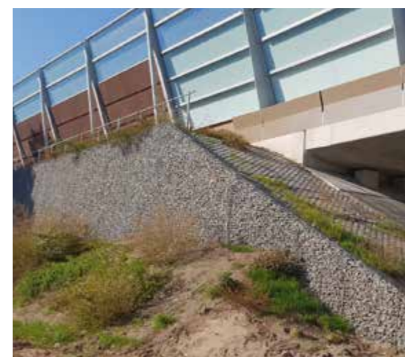
Autobahnausbau mit Grundflächenbeibehaltung Niederlande | 6-spuriger Ausbau einer Teilstrecke bei Utrecht (A1/A27) – Umbau des natürlich abfallenden Autobahndamms zu einer Steilböschung mit Fortrac Gabion Ankerstabsystem – Aufsatz von Lärmschutzwand war auf im System integrierten Betonpfählen möglich.
