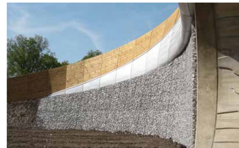
Moderne Wildbrücke über die Autobahn A2 Niederlande | Grünbrücke bzw. Wildbrücke über die Autobahn A2 – Geschwungene Anrampung mit architektonisch modernem Aufsatz – Umsetzung der Fortrac- Bewehrten-Erde in Kombination mit einer Halbgabionenverkleidung – Höhe ca. 8 m.
