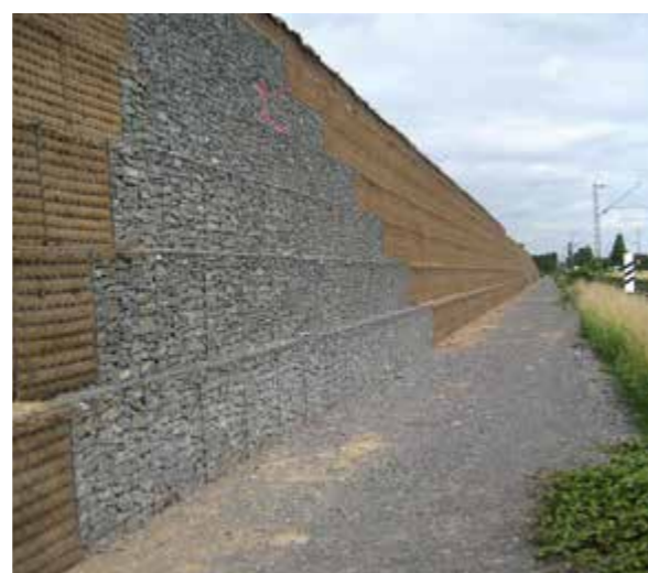
Lärmschutzwand für ein Wohngebiet in Neuss Deutschland | Bebauungsgebiet an Bahnstrecke und Kreisstraße – Kombination Vollgabionenwand zu Gleisen, Naturböschung zur Wohnbebauung – Befüllung der Gabionen mit Steinen, aber auch mit Erde + Bepflanzung – Höhe 10 m und 68^\circ gleisseitiger Neigungswinkel.
