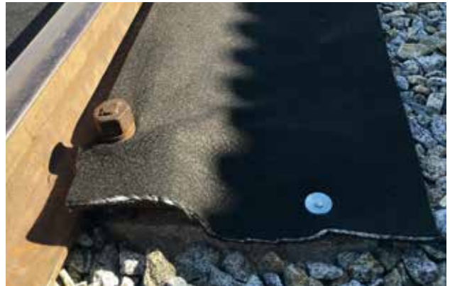
Fissaggio sulla parte esterna ai binari
