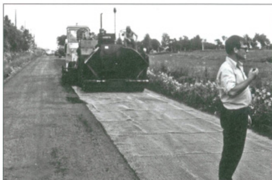
Erste Anwendungen einer Asphaltbewehrung Ende der 60er-Jahre
