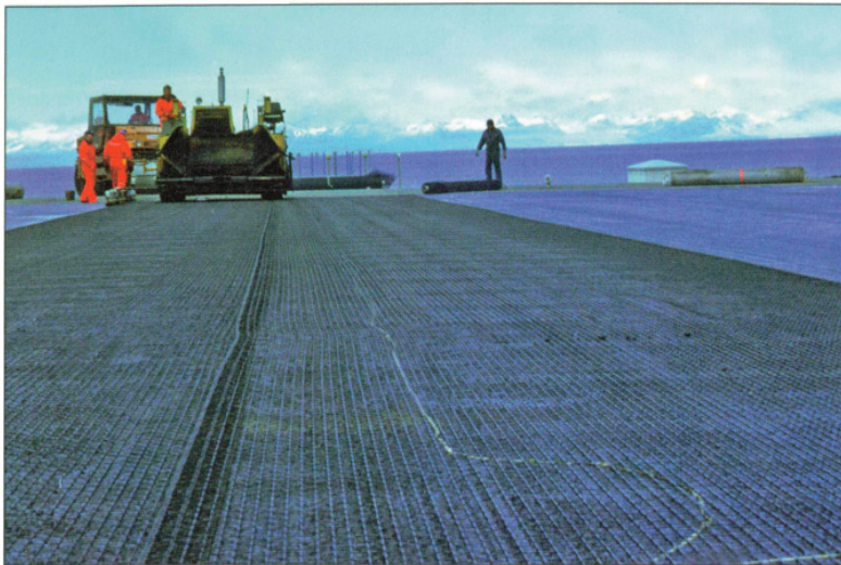
Landebahnsanierung auf Spitzbergen (1989)
