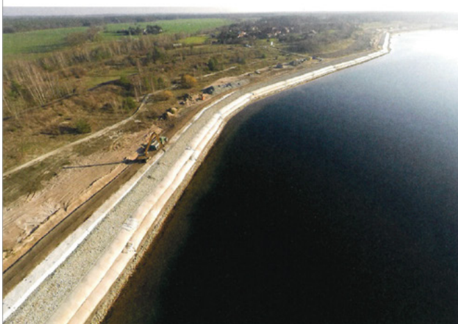
Bild 10: Fertiggestellter Abschnitt der Kliffsicherung Lieske mit SoilTain-Küstenschutzschläuchen
