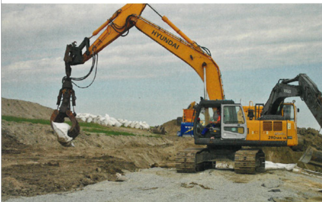
Bild 3: Installationsvorgang des 1-m 3 -Sandsackes mit Hilfe eines modifizierten Sortiergreifers
