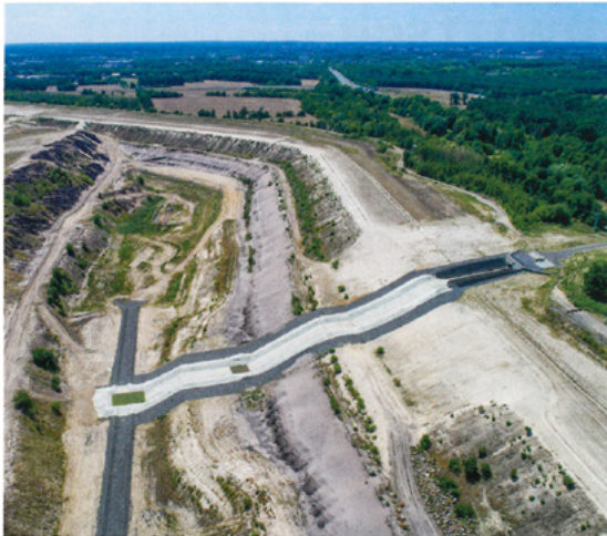
Bild 11: Betoniertes Flutungsbauelement vor Inbetriebnahme
