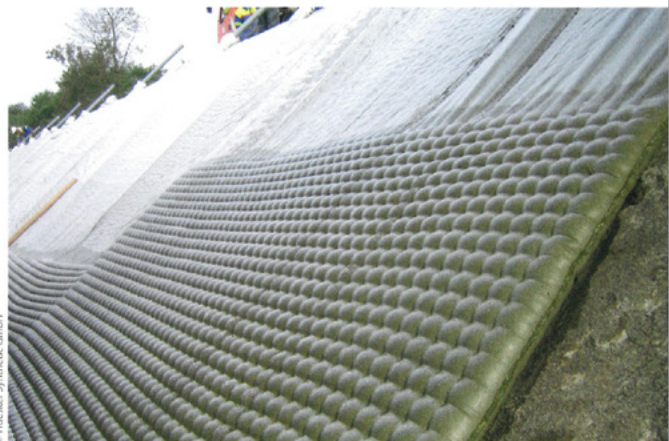
Bild 6: In der Befüllungsphase befindliche Betonmatte
