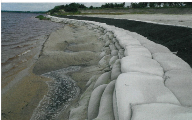
Bild 9: Mit Sandcontainern des Typs SoilTain gesichertes Nordufer
