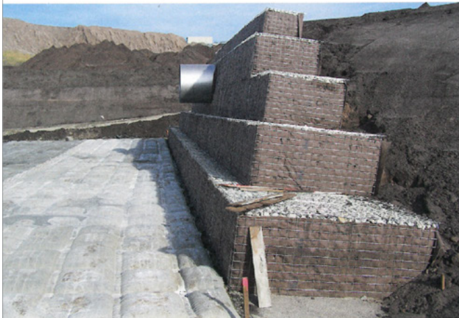
Bild 8: Mit Betonmatte gesicherter Bereich unterhalb des Einlaufrohres
