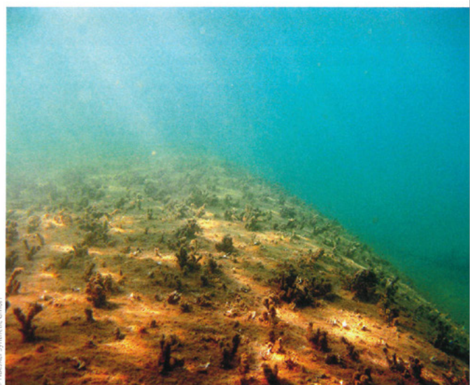
Bild 1: Durch die Marine Flora und Fauna kolonialisierte Oberfläche eines Riffwellenbrechers aus geotextilen Schläuchen im Mittelmeer ca. ein Jahr nach Installation
