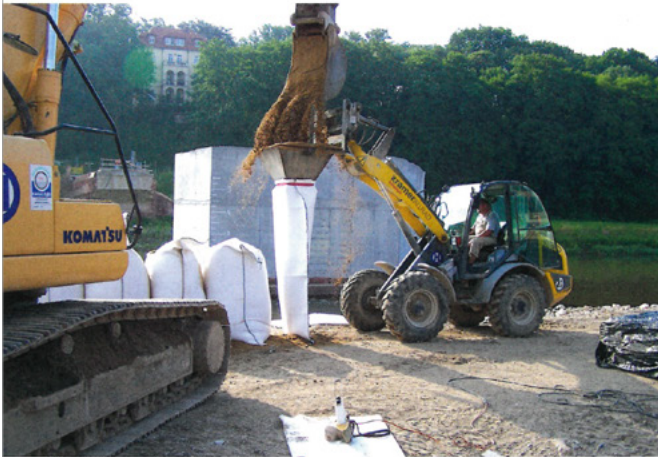
Bild 2: Typischer Befüllvorgang eines geotextilen Sand Bags mit Hilfe eines mobilen Trichters
