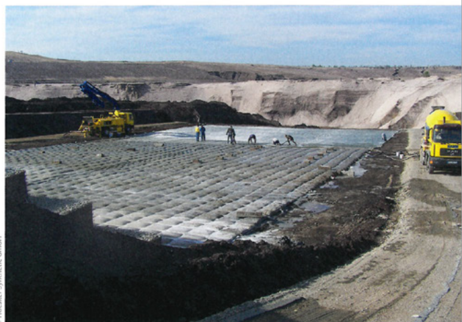
Bild 7: Installation der Betonmatte Incomat Flex 20.118 im Tosbecken
