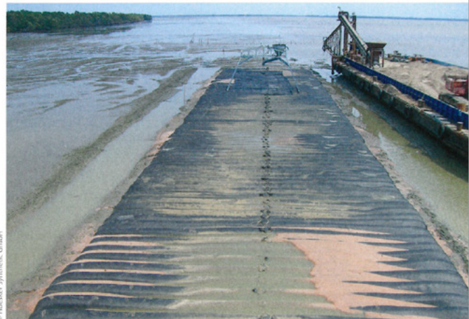
Bild 5: Verfüllte Schlauchmatte als Fundamentsmatte für einen Schlauchwellenbrecher
