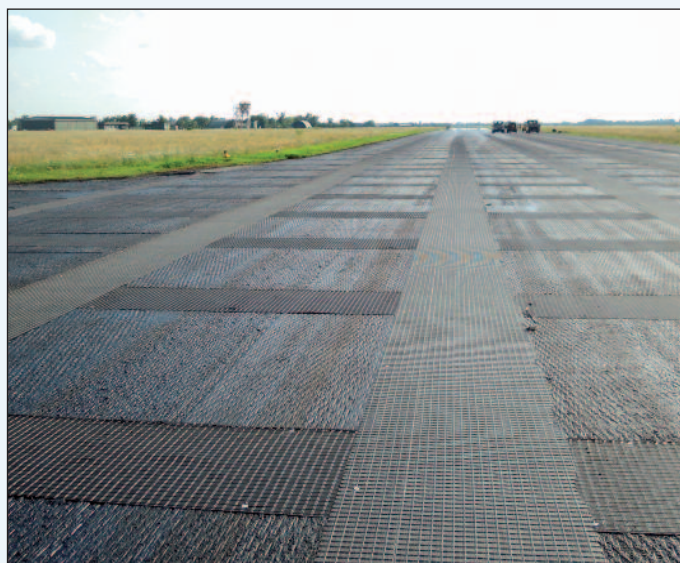
Figura 9 - La griglia HaTelit C 40/17 posata sopra i giunti
