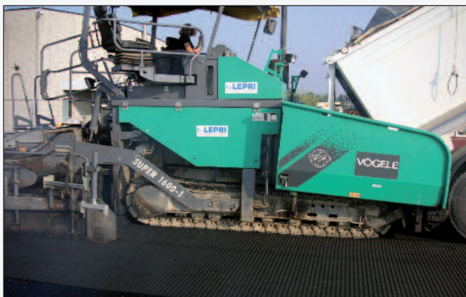
Figura 10 - Una finitrice che transita direttamente sull'HaTelit® C 40/17
