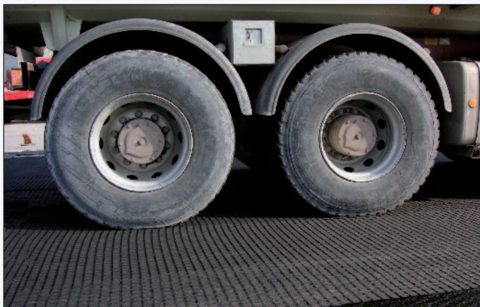
Figura 11 - Un camion che transita direttamente sull'HaTelit® C 40/17
