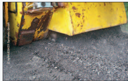
Figura 12 - La fresatura della pavimentazione in conglomerato bituminoso
