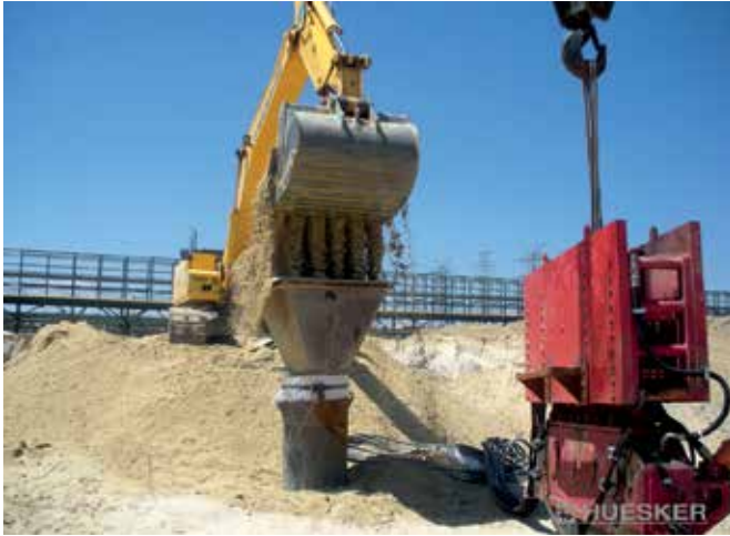
Figura 7 – Exemplo de preenchimento das colunas com material granular
