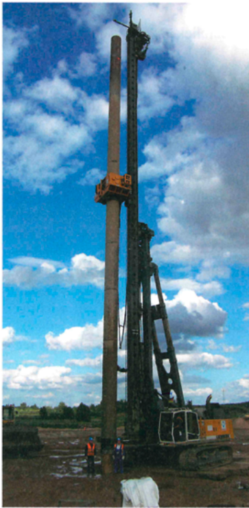
Bild 1. Einbau einer 30 m langen geokunststoffummantelten Säule Fig. 1. Installation of a 30-meter-long geotextile-encased column
