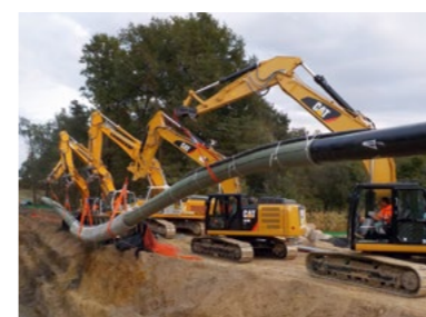
2014 Rivestimento condotta, Francia, Artère de l'Adour, Gasdotto
