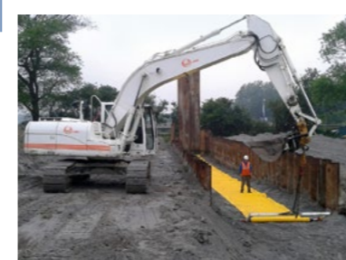
2013 Griglia di segnalazione condotta, Francia, Cantiere Loon-Plage, Gasdotto
