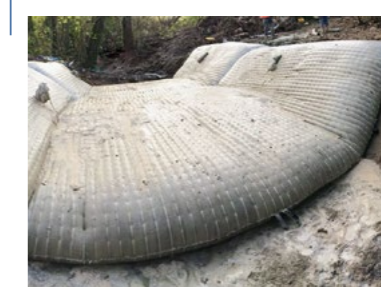
2015 Sistema contro l'erosione dei corsi d'acqua sopra le condotte, Francia, Gasdotto
