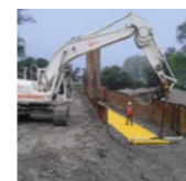
1. Srotolamento sulla condotta
