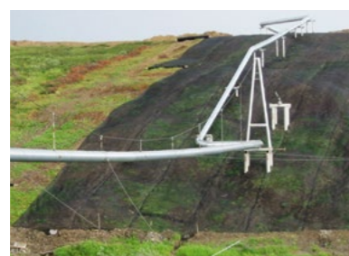
2004 Stabilizzazione pendii, Russia, Baku-Novorossiysk, Oleodotto
