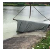
1. Posa dei pannelli
