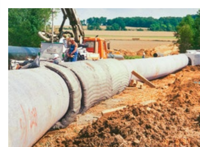
1997 Rivestimento condotta, sifone invertito, Francia, Fiume Luce, Gasdotto
