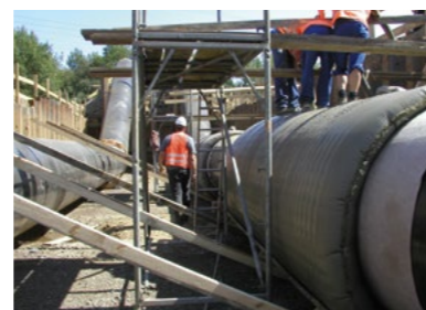
2009 Rivestimento condotta, sifone invertito, Germania, Essen, Gasdotto
