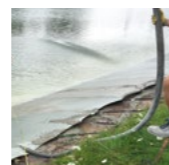
3. Riempire i pannelli con calcestruzzo fluido
