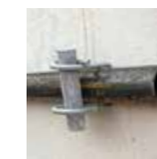
Connettori per paramento esterno attivo
