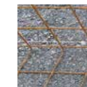
Cassero a perdere provvisorio per paramento passivo
