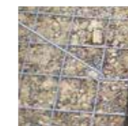
Cassero in rete elettrosaldata zincata
