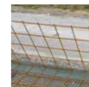
Cassero in rete elettrosaldata
