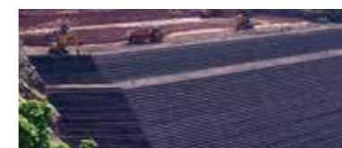
Terre rinforzate Opere di sostegno, scarpate rinforzate
