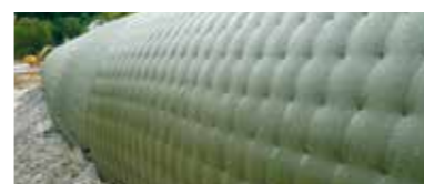
Incomat® Pipeline Cover Materassi in calcestruzzo per il rivestimento di condotte
