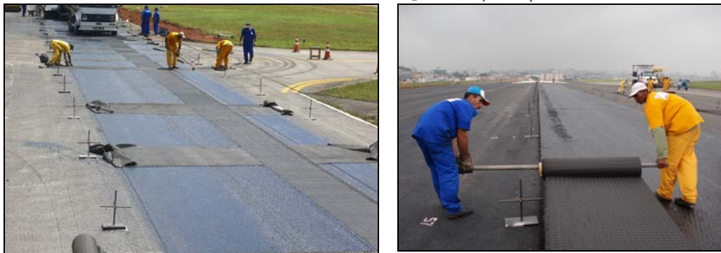
Figura 7: Instalação da geogrelha na direções longitudinais e transversais
