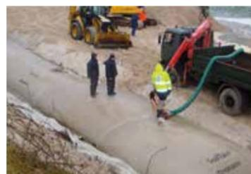
Riempimento dei geotessili tubolari (draga aspirante, pompa)
