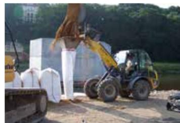
Riempimento meccanico mediante escavatore e tramoggia
