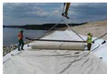
Posa in opera dei geotessili tubolari (per es. con il nostro dispositivo per la posa)
